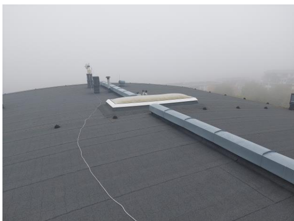
foto /5/ Pohled na směr kladení pásů
