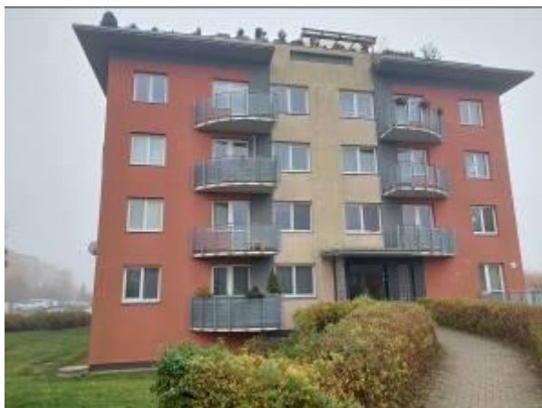
foto /1/ Pohled na čelní stranu stavby
