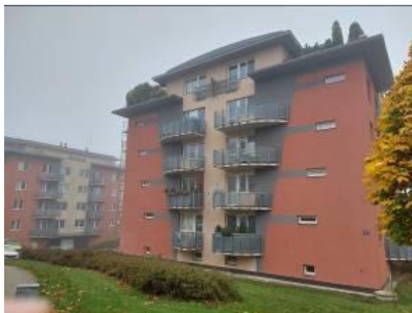
foto /2/ Pohled na boční stranu stavby
